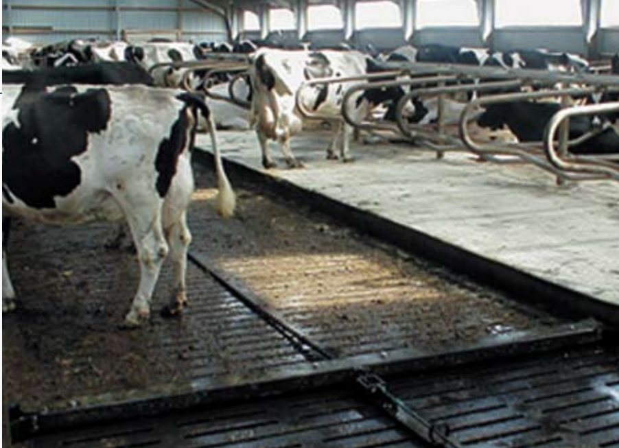
Figur 1. Spalteskraberen holder spaltegulvets overflade ren for gødning og urin og reducerer ammoniakfordampningen med ca. 20 procent.
