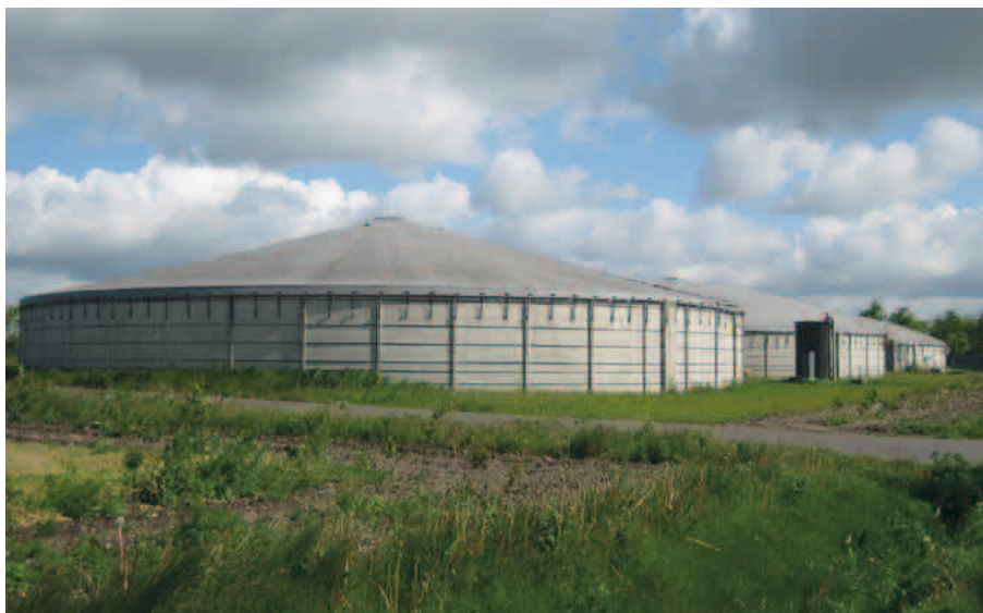
Overdækning af gyllebeholdere kan reducere metanudledningen ved at øge den bakterielle omdannelse af metan til CO 2 , inden det tabes i atmosfæren.
